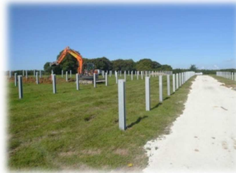
Ci-contre un exemple de voie d'accès en grave non traitée
